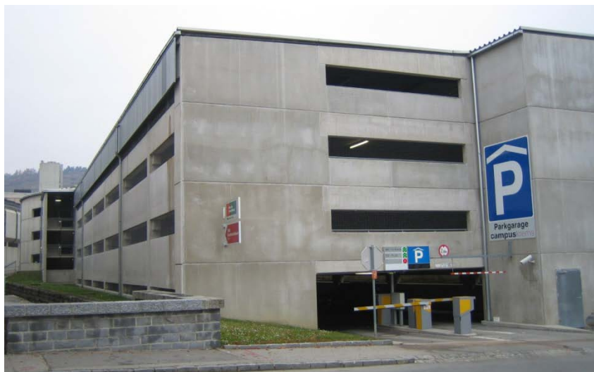
Abbildung 8: Parkdeck Steiner Landstraße (Quelle: eigenes Foto)
