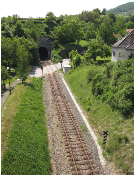
Abbildung 18: Hier wird links des Gleises die Station Krems Zentrum errichtet
