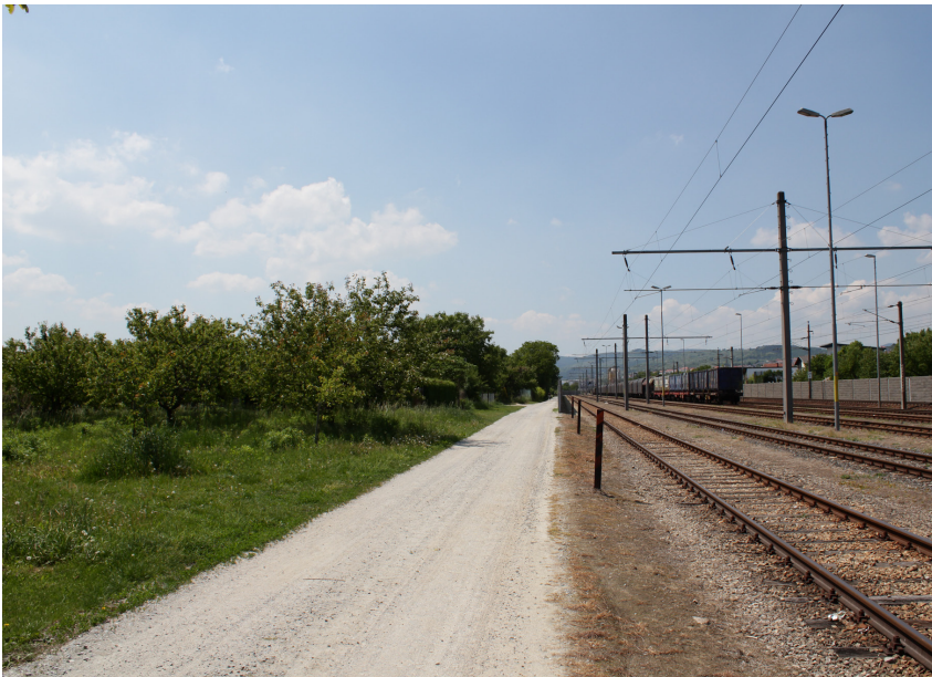
Abbildung 16: Blick auf das Erweiterungsgebiet aus NO
