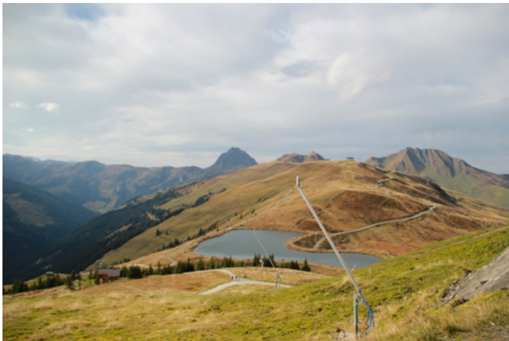
Abb.12 Speichersee Resterhöhe, Hollersbach
