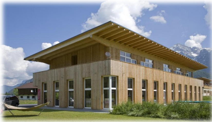
Abb. 39 Betriebsgebäude St.Ulrich am Pillersee, Tirol
