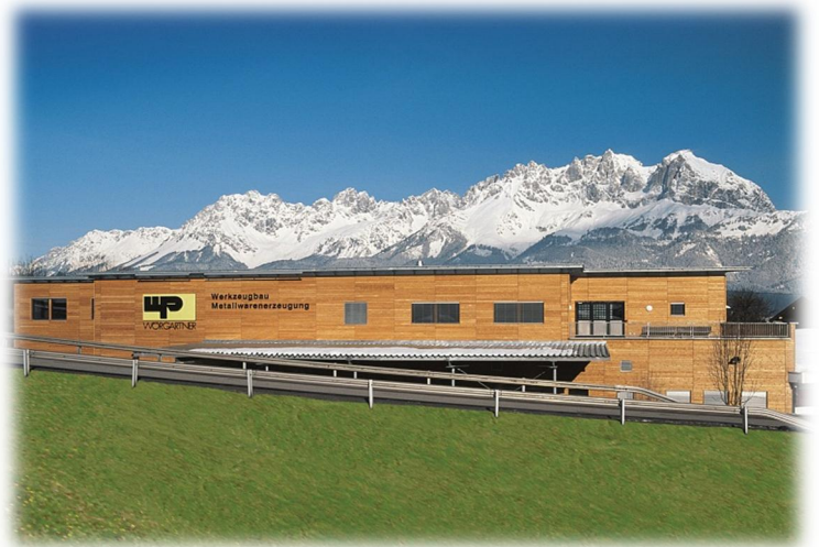
Abb. 40 Betriebsgebäude Wörgartner, Tirol
