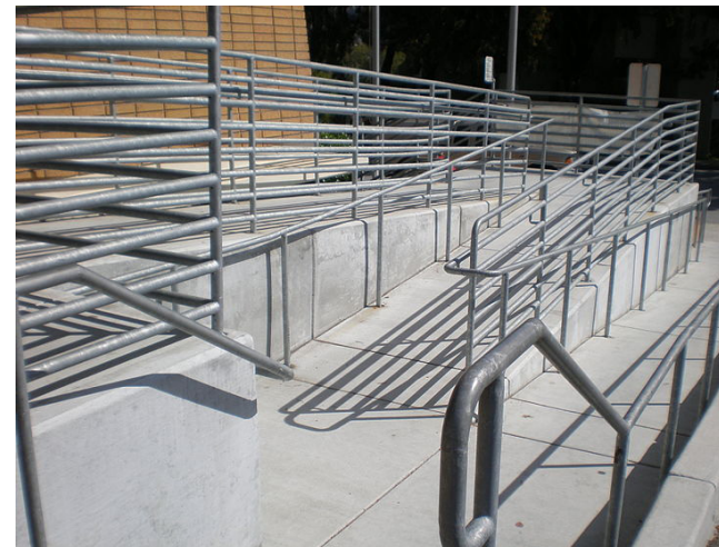
Abb. 99: Rollstuhlrampe - Wikimedia Foundation Inc. 2008
