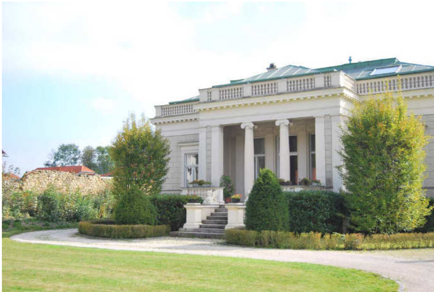
Abb. 21 – Hansen Villa in Pressbaum | Quelle: eigene Aufnahme
