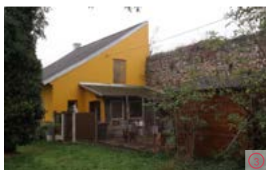
Abb. 12.6: Haus direkt an der Stadtmauer
