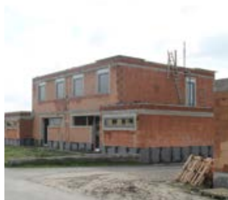
Abbildung 10.74: Baustelle im Bahnhofsviertel
