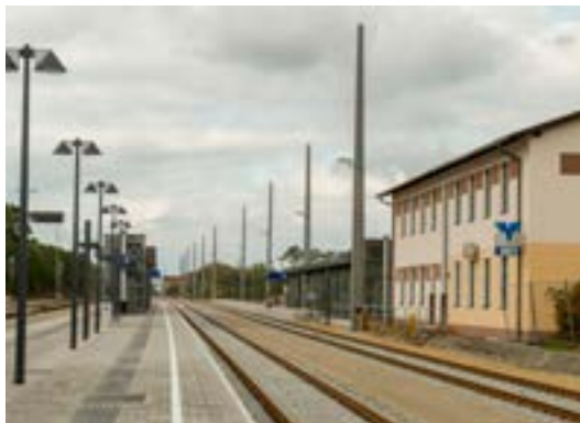
Abb. 2.6.3.: Der Umbau hat bereits begonnen
