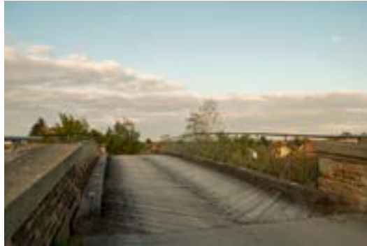
Abb. 2.3.1.5: Brücke Marchegg Bahnhof
