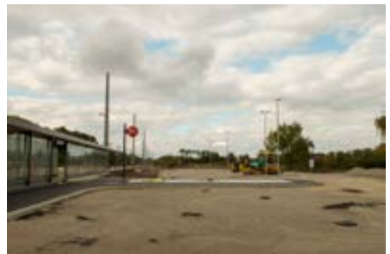
Abb. 2.6.4.: Hier entsteht die Park&Ride- und Fahrradabstellanlage
