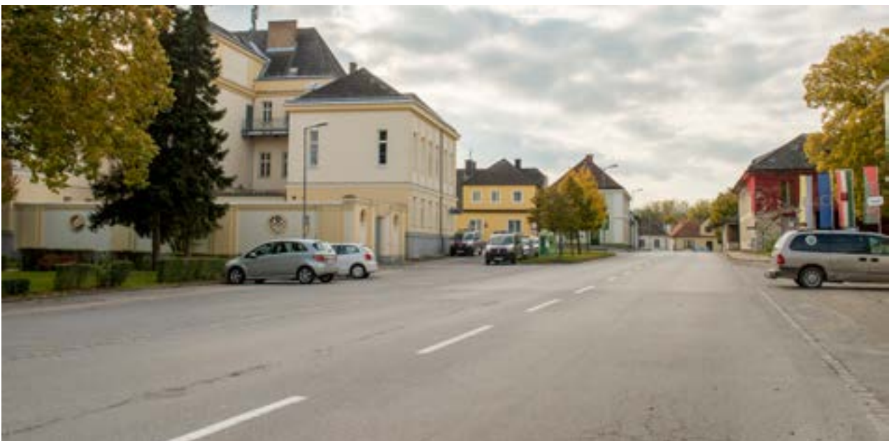
Abb. 2.7.7: Fehlender Schutzweg zwischen Stadtzentrum und Schloss Marchegg
