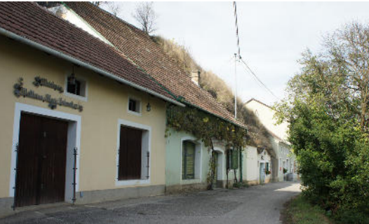
Abb.10.5.5.27: Beginn/Ende (Norden) Quelle: eigene Aufnahme
