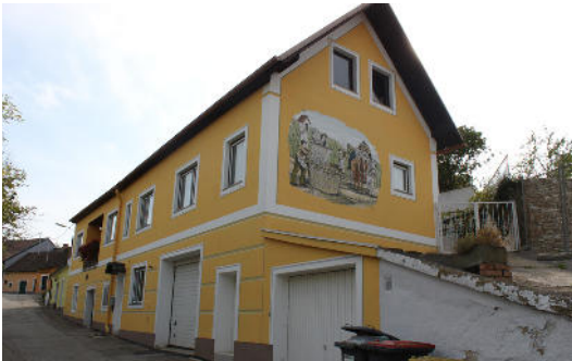
Abb.10.5.2.13: Erster Blick in den Lissgraben Quelle: eigene Aufnahme
