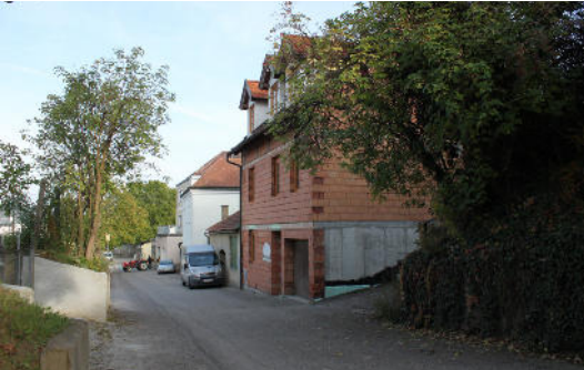
Abb.10.5.2.55: Dimmelgraben Quelle: eigene Aufnahme
