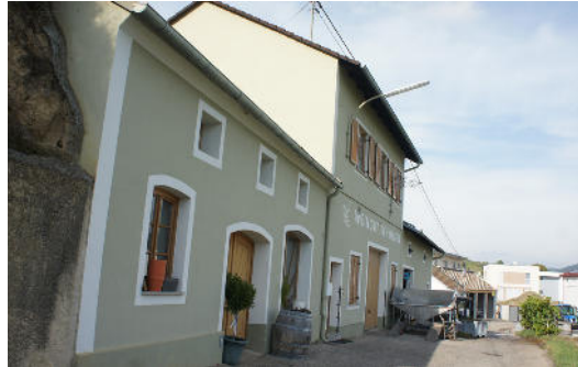
Abb.10.5.5.26: Weinbau Quelle: eigene Aufnahme
