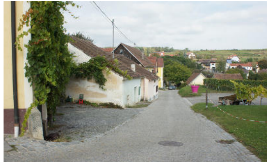
Abb.10.5.4.4: unterer Bereich einseitig offen Quelle: eigene Aufnahme
