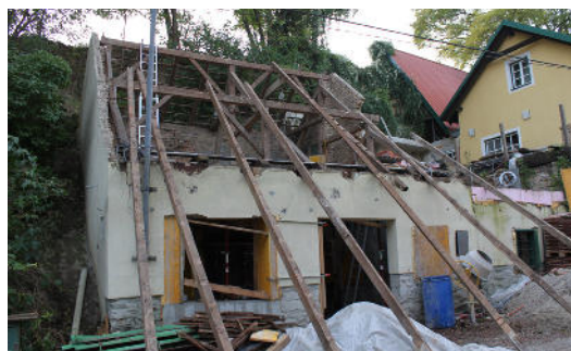
Abb. 10.5.2.4: Im Bau befindlich Quelle: eigene Aufnahme
