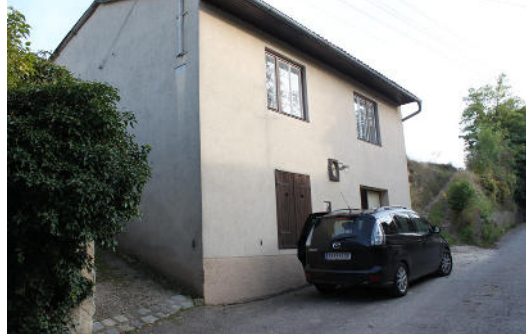
Abb. 10.5.2.62: Atelier von Außen Quelle: eigene Aufnahme
