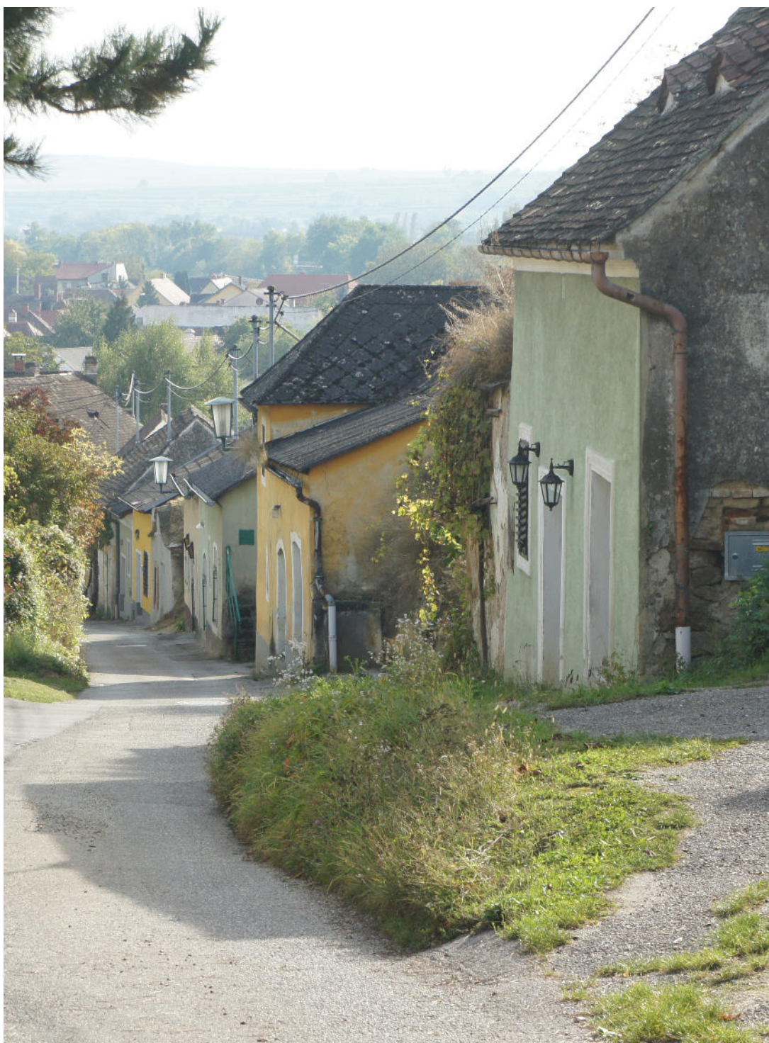
Abb.10.5.1: Kellergassen Quelle: eigene Aufnahme
