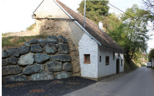
Abb.10.5.2.44: Zustand nach Veränderung Quelle: eigene Aufnahme
