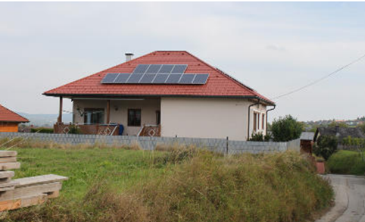
Abb.10.5.2.27: Neubau Solarpanels Weraingr. Quelle: eigene Aufnahme
