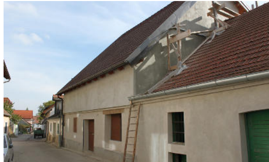
Abb.10.5.2.28: Aufstockung Weraingraben Quelle: eigene Aufnahme
