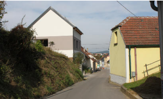
Abb.10.5.2.45: Blick in die Ziegelofengasse Quelle: eigene Aufnahme
