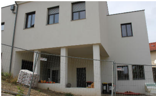
Abb. 10.5.2.15: Neubau Lissgraben Quelle: eigene Aufnahme
