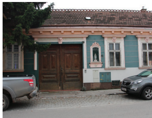
Abb. 7.52: eingeschossiges Gassenfrontheus in Probstdorf. eigene Aufnahme
