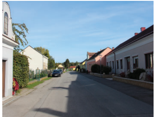
Abb. 7.74: Straßenrandbebauung in Schönau an der Donau. eigene Aufnahme
