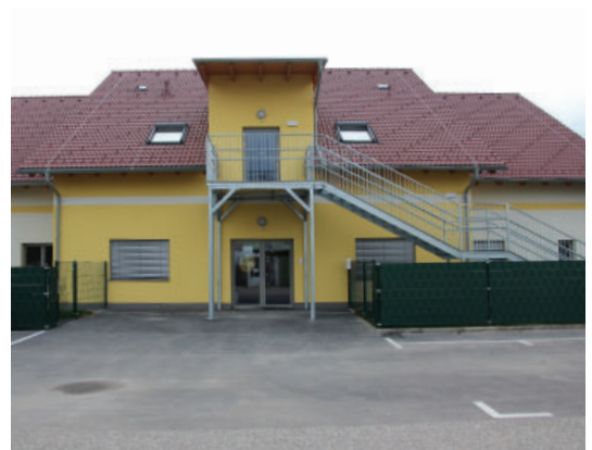
Abb. 7.46: Neueröffneter Kindergarten in Oberhausen. eigene Aufnahme
