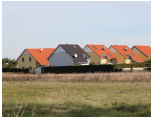
Abb. 7.7: Einfamilienhaussiedlung im Westen von Franzensdorf. eigene Aufnahme
