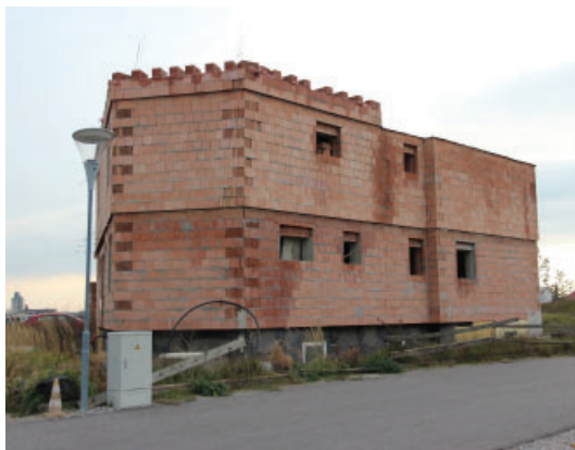
Abb. 7.43: Rohbau in Neu-Oberhausen. eigene Aufnahme
