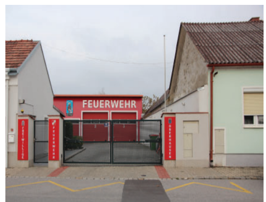
Abb. 7.39: Gebäude der Freiwilligen Feuerwehr an der Dorfstraße in Oberhausen. eigene Aufnahme
