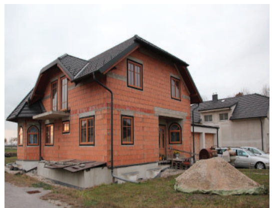
Abb. 7.66: Neubau an der Straße Neues Dorf in Rutzendorf. eigene Aufnahme
