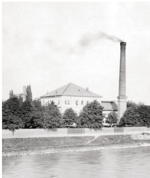
Abb. 3.14, Wasserwerk Körösistraße 1890, holding-graz
