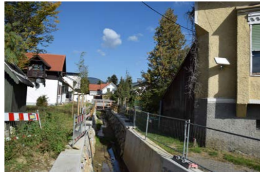
Abb. 4.28: Schutzverbauung beim Gabrielbach, eigene Aufnahme
