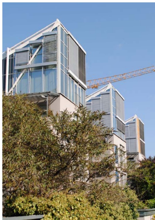
Abb. 5.42: Wohngebäude in Andritz. Quelle: Plachetzky, 2022
