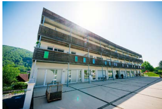
Abb. 6.46: Generationenhaus Stattegg mit Kinderkrippe - Quelle: WIKI 2022j
