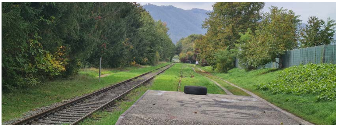
Abb. 8.15: Schleppbahntrasse mit Blick Richtung Westen. Quelle: Gartner, 2022
