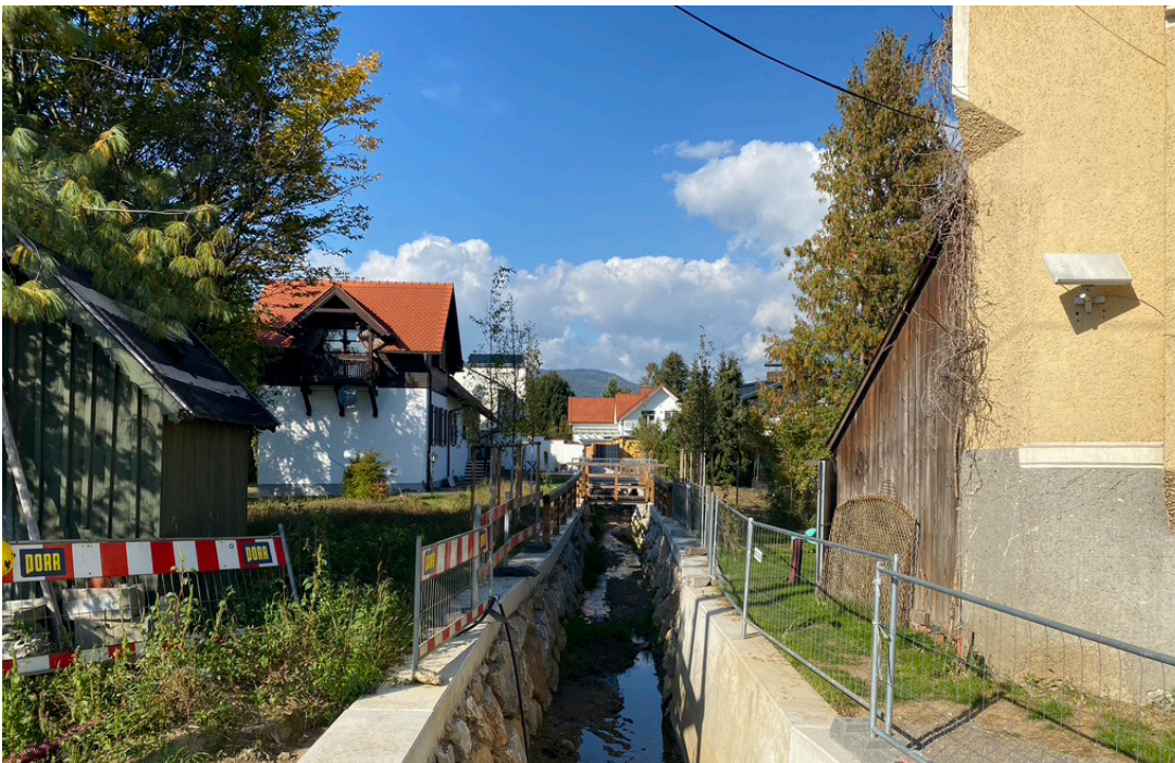
Abb. 11.45 Gebäude in Andritz
