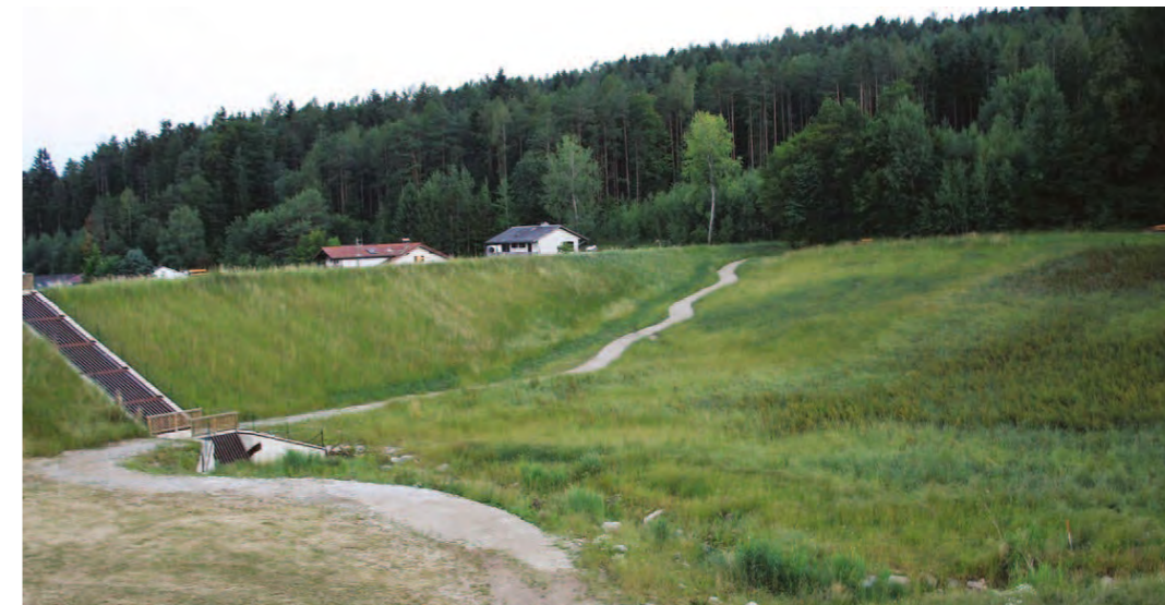
Abb. 15 Hochwasserspeicher leer, Bestandsanalyse 2022, S.114
