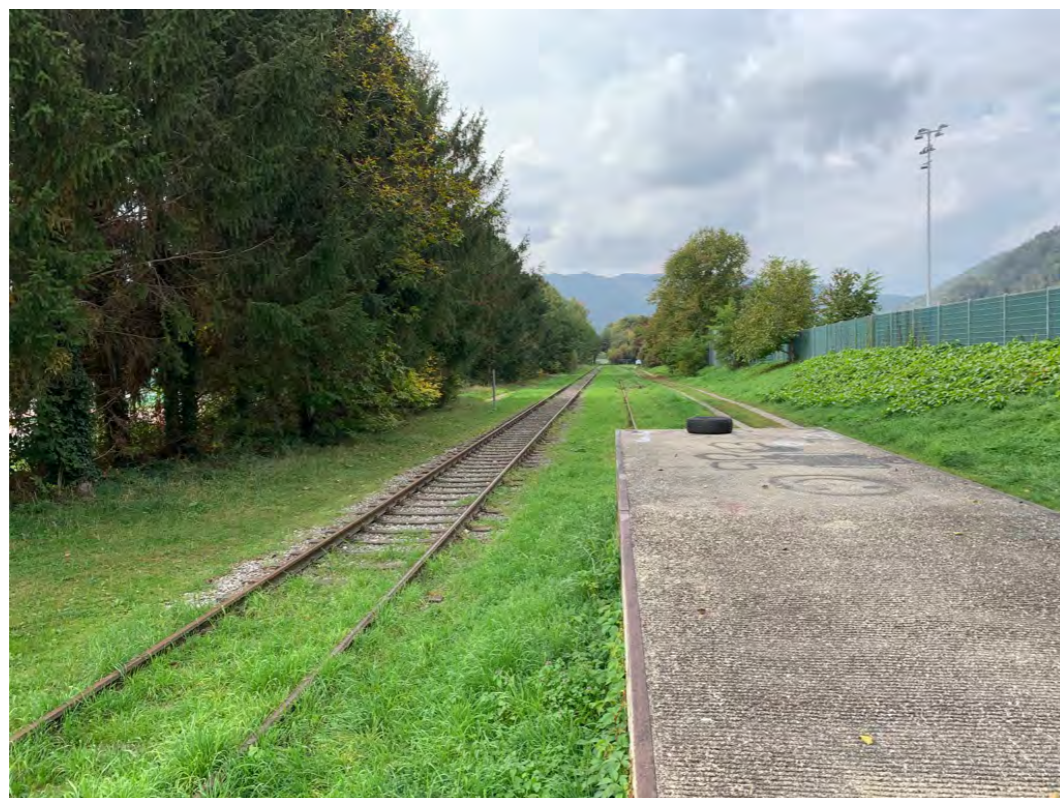
Abb. 109 Schienen der Andritz AG, eigene Aufnahme
