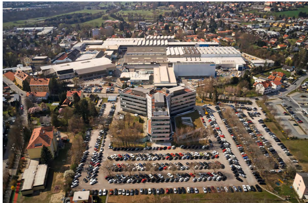
Abb. 77 Parkplatz der Andritz AG, AT-Minerals
