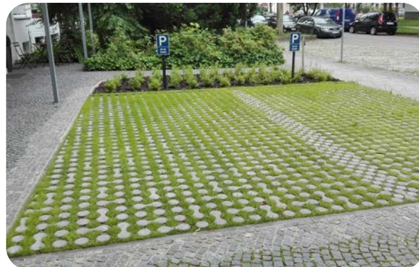
Abbildung 6.2.17: Referenz Parkplatzbelag (Godelmann, 2023)
