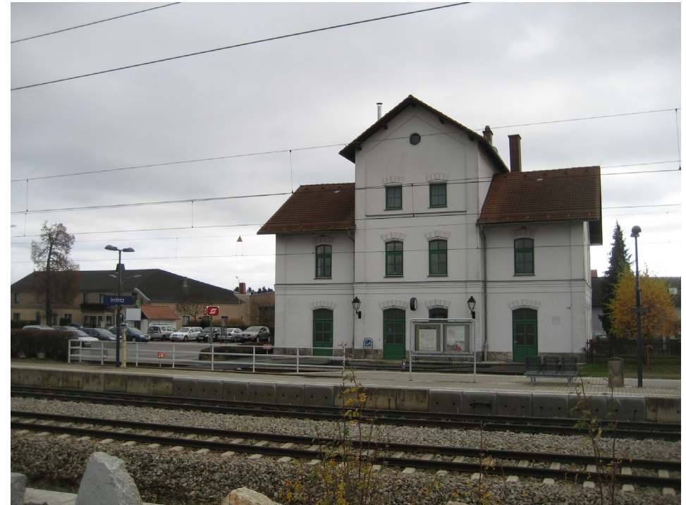
Abb. 13.2 . Bahnhof Irnfritz an der Franz-Josefs-Bahn
