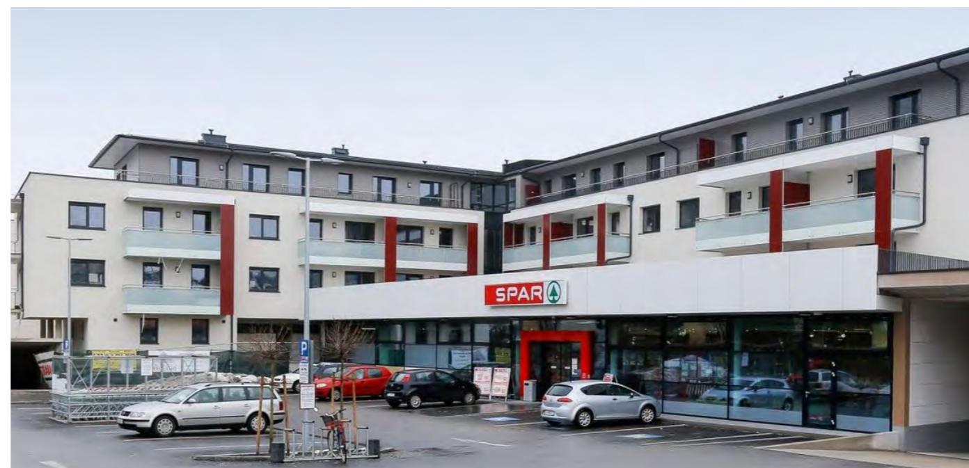
Abb. 140: Gebäude mit Mischnutzung in Salzburg
