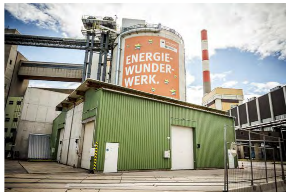
Abb. 149: Biomassekraftwerk in Simmering, wienenergie.at
