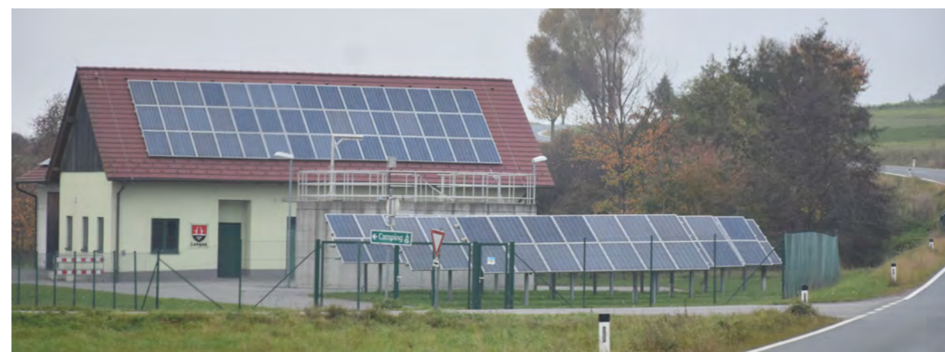
Abb. 150: Bereits umgesetzte Photovoltaikanlagen ab Beispiel der Abwasserreinigungsanlage Langau, Quelle: eigene Aufnahmen
